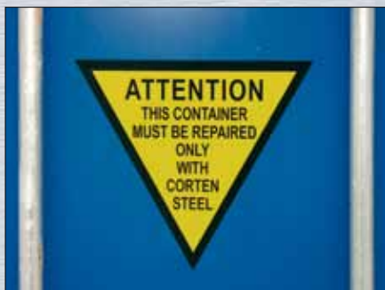
Tôle en acier Corten (anti-corrosion)
